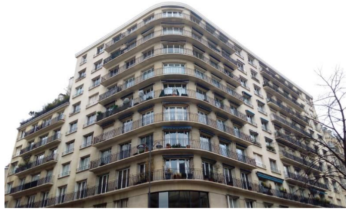
Cliché avec HDR
